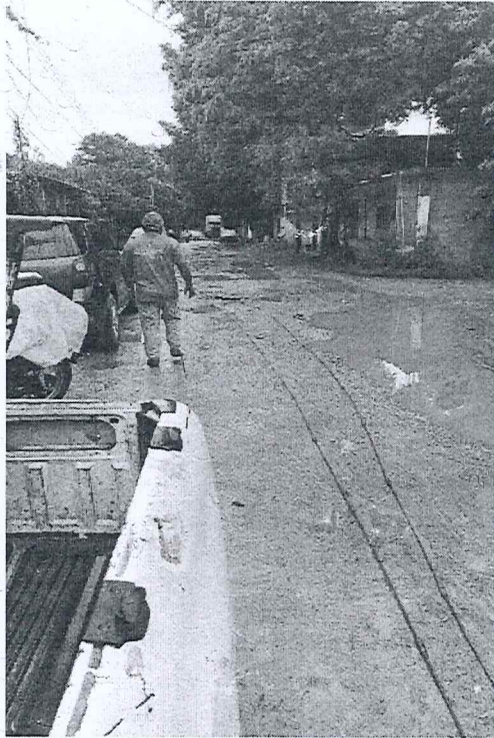
JUNIO DESAZOLVE LINEA PRINCIPAL DE DRENAJE, COLONIA SAN FRANCISCO
