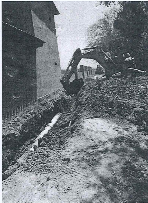
MARZO REPARACION DE FUGA DE AGUA DE 12", SABINITO PLAN
