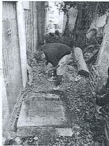
ENERO DESASOLVE DE DRENAJE, COLONIA CARLOS JONGUITUD BARRIOS
