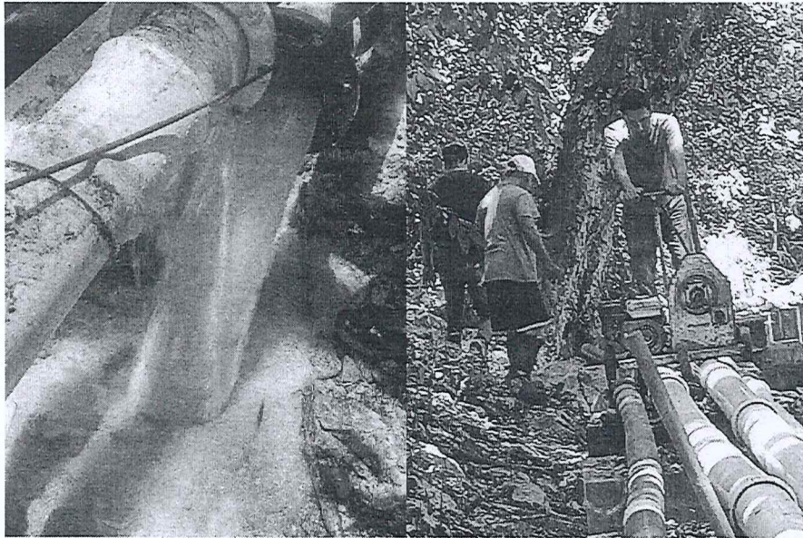
MAYO LIMPIEZA DE LINEA PRINCIPAL QUE ABASTECE A LAS COLONIAS, LA PRESA, EL COLORADO Y GRANJAS.
