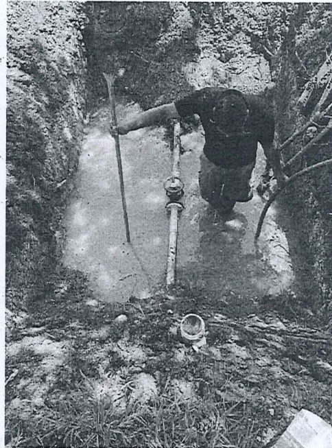
AGOSTO TRABAJOS DE MANTENIMIENTO EN LA LINEA PRINCIPAL QUE ABASTECE A CONGREGACION LA MUTUA
