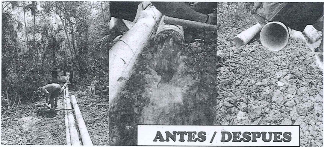
MARZO TRABAJOS DE LIMPIEZA. COLONIA AGRICOLA EL
