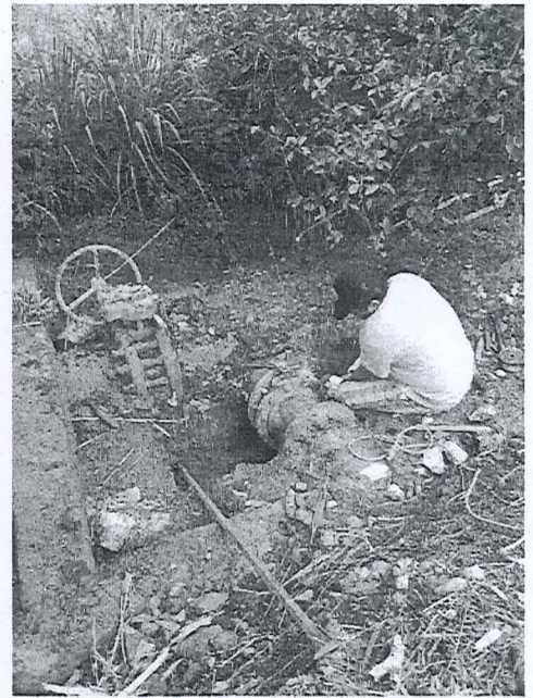
MAYO MANTENIMIENTO A LAS VALVULAS DE 18", AREA DE BOMBAS
