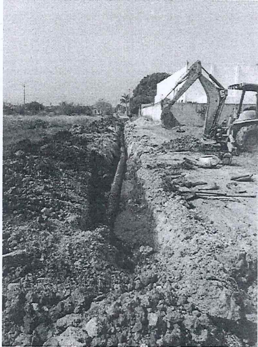
FEBRERO REPOSICIÓN DE LA LINEA DE DRENAJE, COLONIA LA BAHIA.
