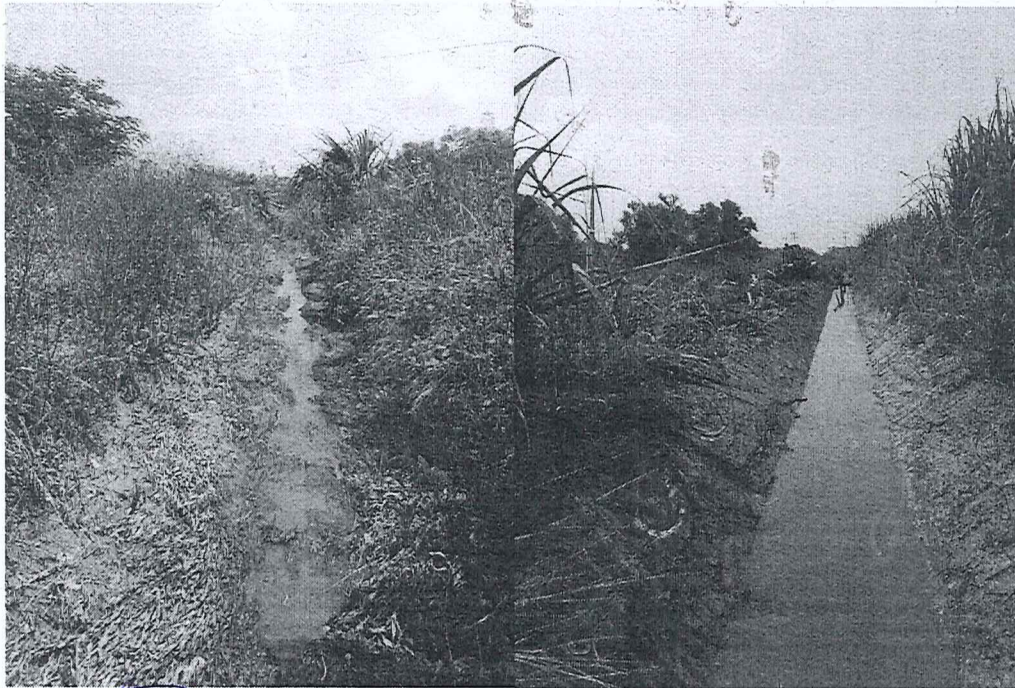
JUNIO LIMPIEZA AL CANAL DEL SABINITO, EL CUAL ABASTECE A LAS BOMBAS DE SINAPAS
