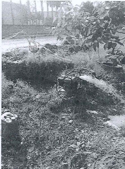
SEPTIEMBRE TRABAJOS DE MANTENIMIENTO LINEA PRINCIPAL DE DRENAJE, ESPERANZA NORTE
